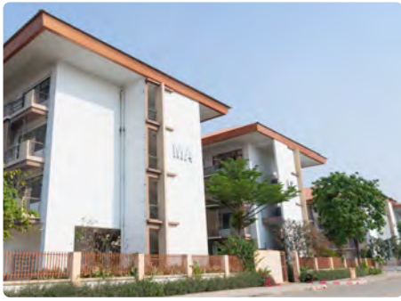
อาคารหอพักนักเรียนชาย
